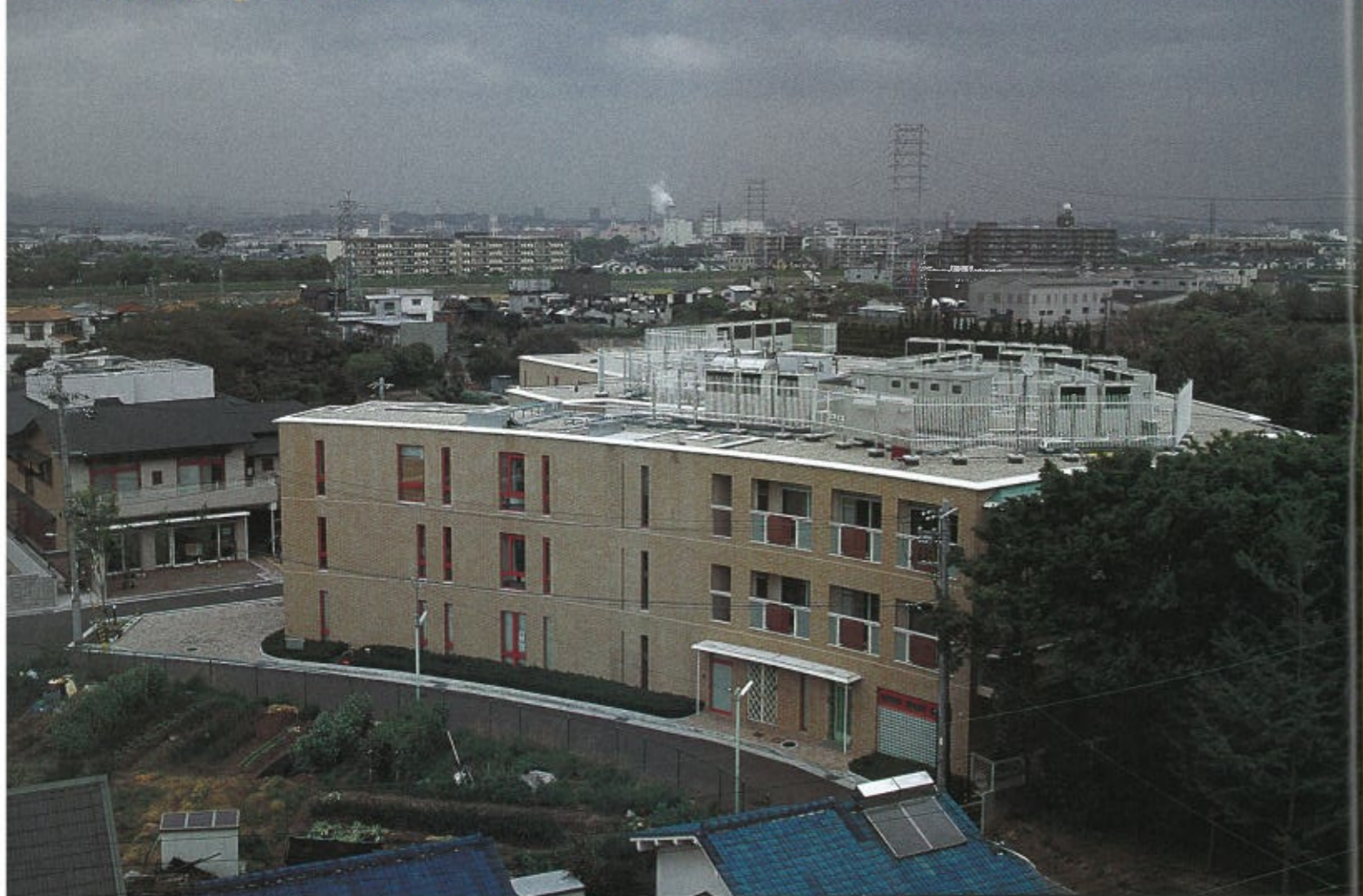
上/「けま喜楽苑」全景。左手に見えるのがグループホーム。右手が特別養護老人ホーム。そのあいだに両者の玄関がある。特養にはバー、グループホーム側には喫茶室もある。玄関まわりは広場的なイメージとしたかったとは設計の永野一先生の言葉。いずれにしる、ふたつの建物のあいだに入っていく道によって落ち着いたアプローチが計画されている。
